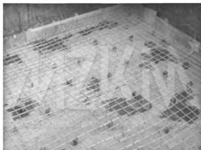
Рисунок 8.3 – Применение АНК для армирования фундаментной плиты<sup>1)</sup>
