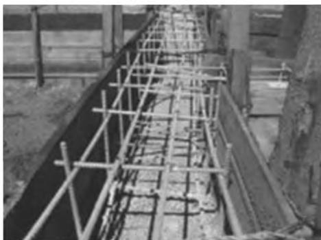
Рисунок 8.6 – Армирование фундамента по периметру сооружения
