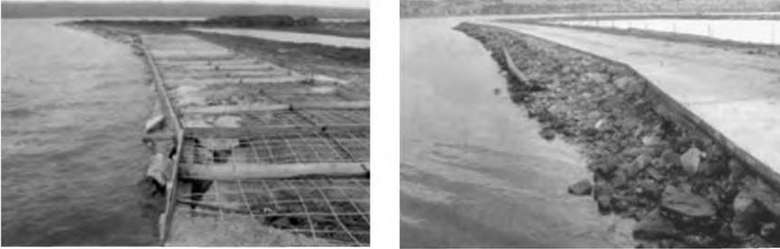
Рисунок 8.23 – Сооружение бунны с использованием композитной арматуры<sup>1)</sup>
