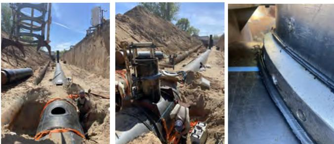
Сварка патрубка выполняется в соответствии с циклограммой сварки напорных ПЭ труб ГОСТ 18599-2001, ГОСТ Р 58121.2
