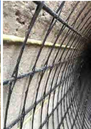
Изготовление тубинга АРМПАЙП выполняется в заводских условиях. Характеристики композитной сетки - основы для тубинга подбираются на основании требуемых характеристик трубопровода АРМПАЙП.
