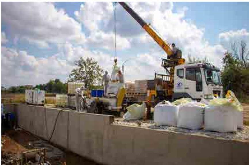
Установка и подготовка узла смешения и подачи высокопрочной смеси в самоходную машину.
