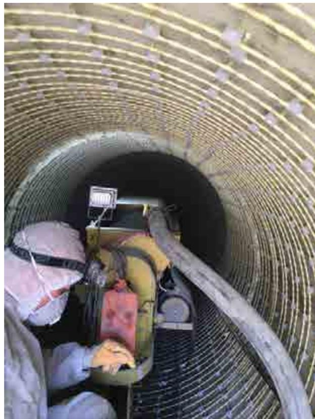
Выполняется установка и центровка самоходной метательной машины в предварительно подготовленный в трубопровод.
